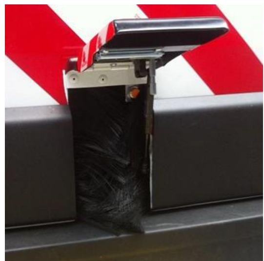
Passage door for cables (optic, TV, électricité, etc.)
